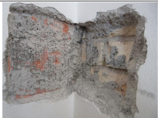
Scarificazione dell'angolata formata dai setti X28-Y18 dell'US1 in cui possibile osservare l'accostamento delle due tipologie di murature.
