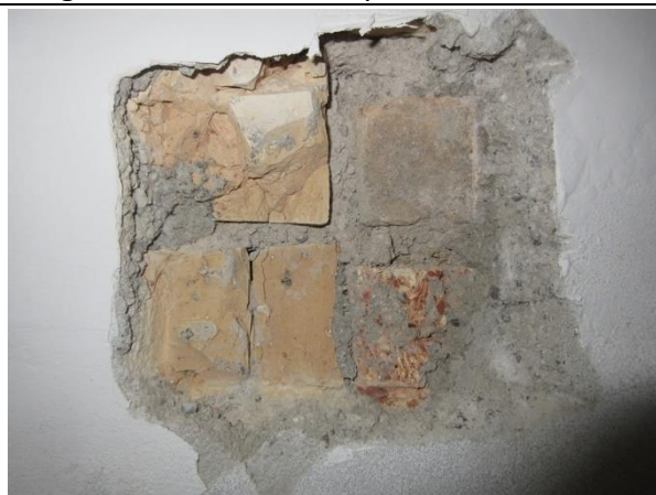
Scarificazione per il rilievo della conformazione costruttiva della muratura, eseguita sul setto Y01 al piano terra dell'US1.
