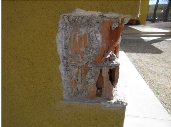
Particolare della conformazione costruttiva della muratura, in cui osservabile lo spessore e l'andamento dei letti di malta.
