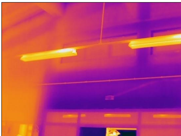
Foto n°2 - Analisi termografica che permette l'individuazione di pilastri in falso su travi.
