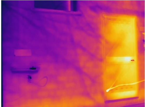
Analisi all'infrarosso eseguita sul fronte Sud dell'US1, in cui osservabile la tramatura caratteristica della muratura.
