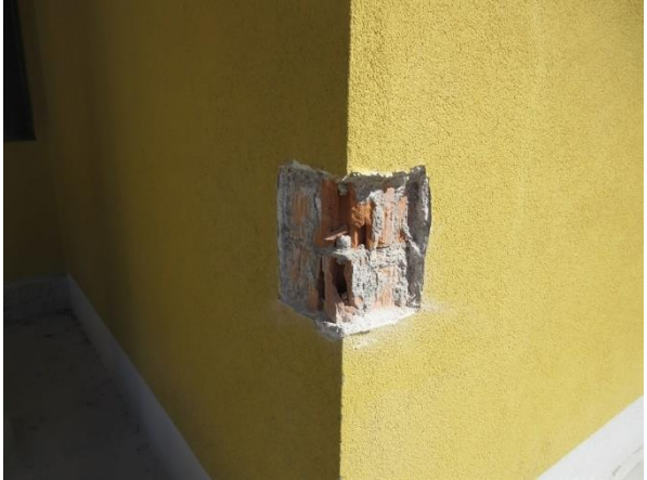
Scarificazione dell'angolata formata dai setti X36-Y18 dell'US1 in cui possibile osservare l'ammorsamento delle murature.
