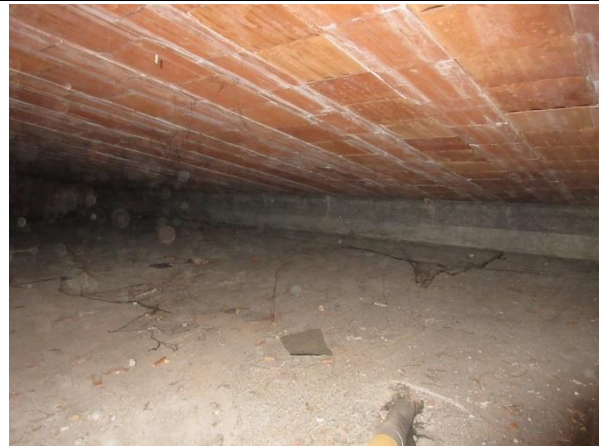
Particolare del cordolo di chiusura su cui si innesta la copertura.
