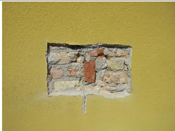
Scarificazione per il rilievo della conformazione costruttiva della muratura, eseguita sul setto Y01 al piano terra dell'US1.
