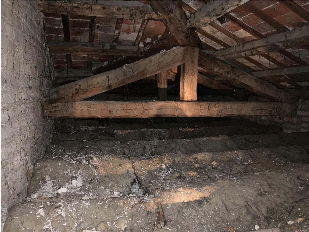
Figura 12: Vista del sottotetto (ala sud)
