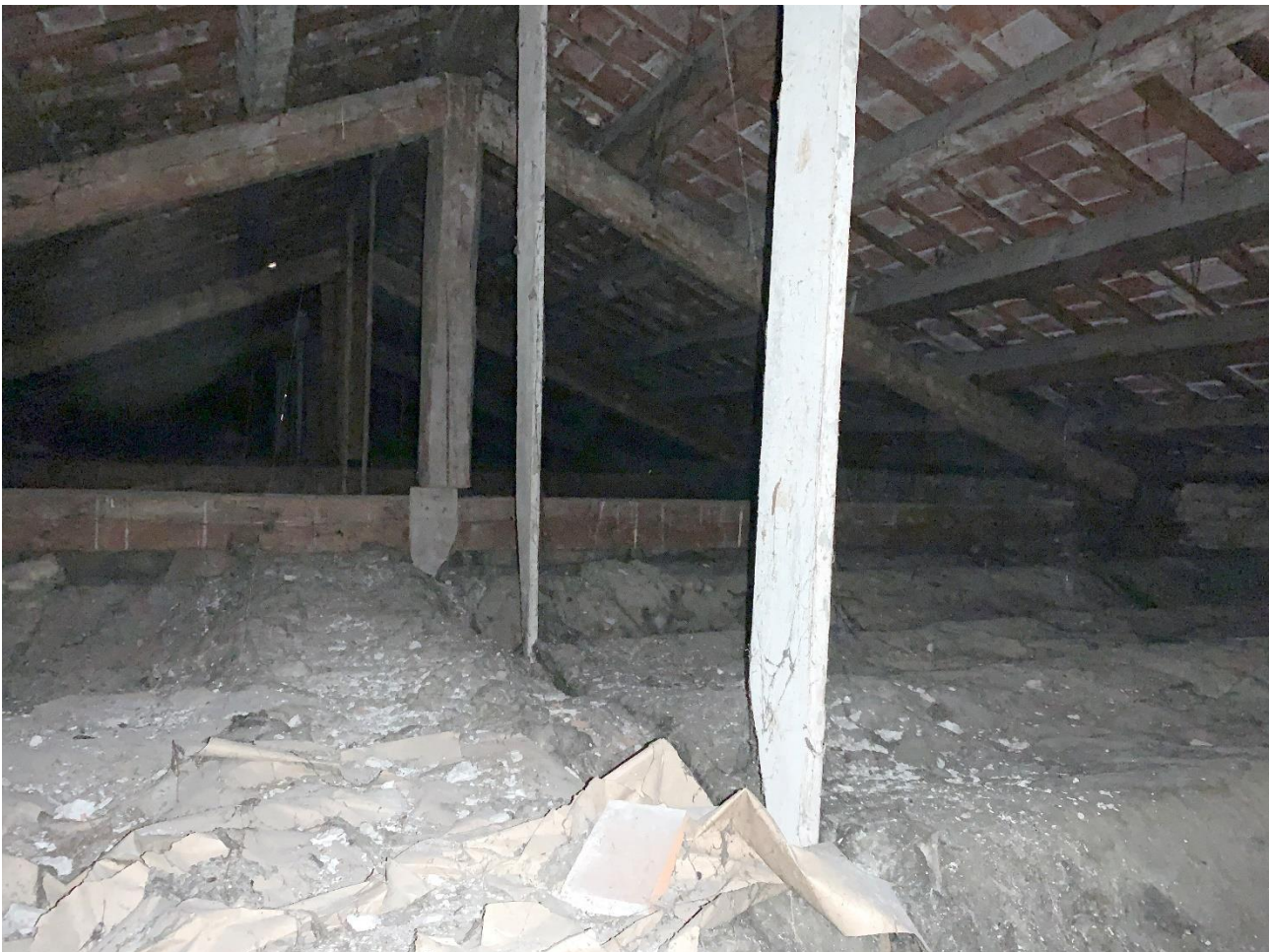
Figura 11: Vista del sottotetto (parte centrale)
