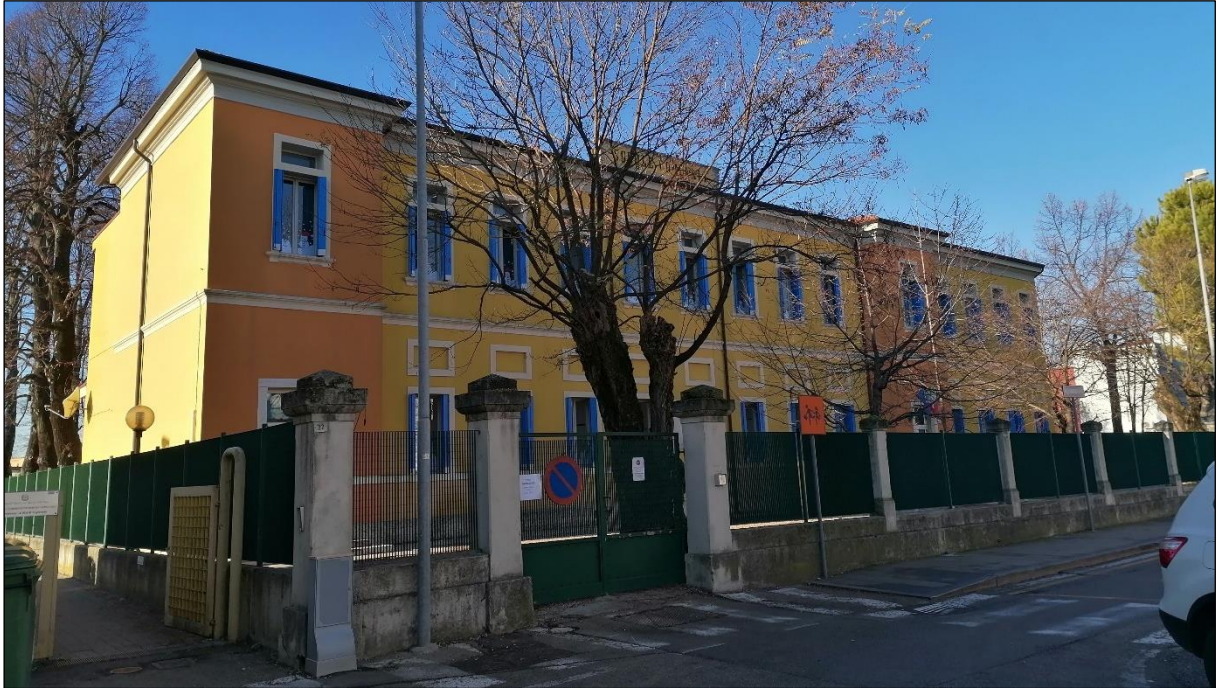
fig. 6: Prospetto principale su via Maggiore
