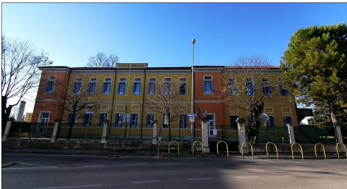
fig. 5: Prospetto principale su via Maggiore
