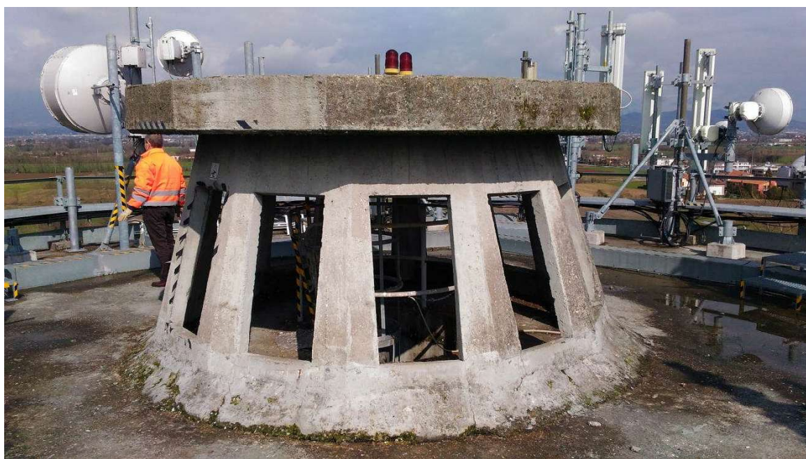
Figura 4 – Vista della cupola di uscita in copertura
