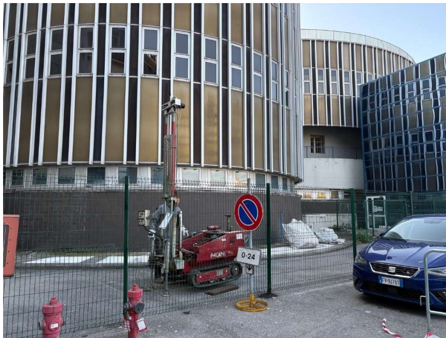
Foto 1 – Prova penetrometrica dinamica SCPT1
