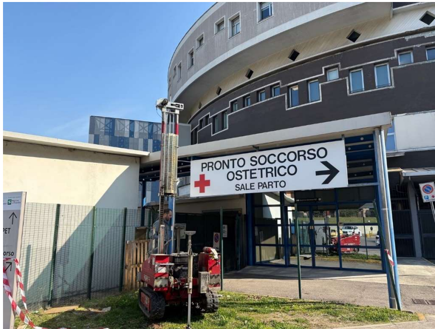
Foto 2 – Prova penetrometrica dinamica SCPT2
