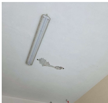
Solaio riscontrato in sito
