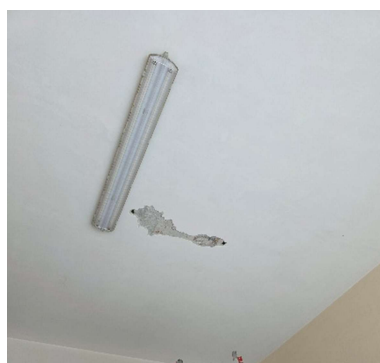
Solaio riscontrato in sito
