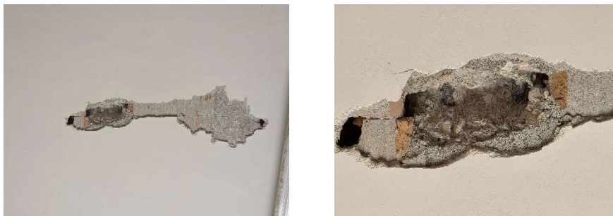
Solaio riscontrato in sito
