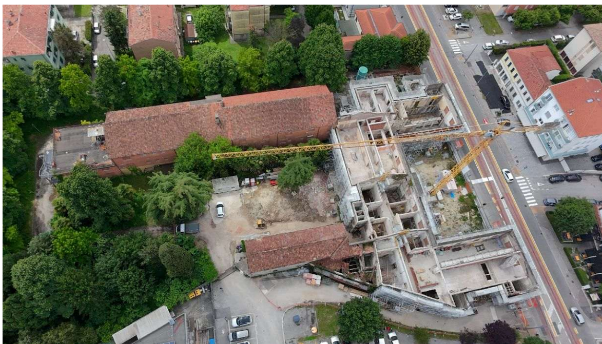
Figura 16 – Foto aerea prima della demolizione (primavera 2025)
